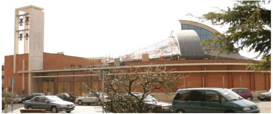
El nuevo templo está situado en el barrio de Torrelago, muy cerca de la laguna. RTD
