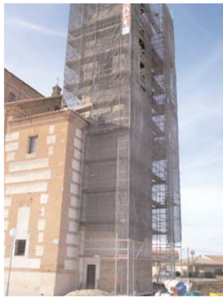
La torre de la Iglesia en obras.
