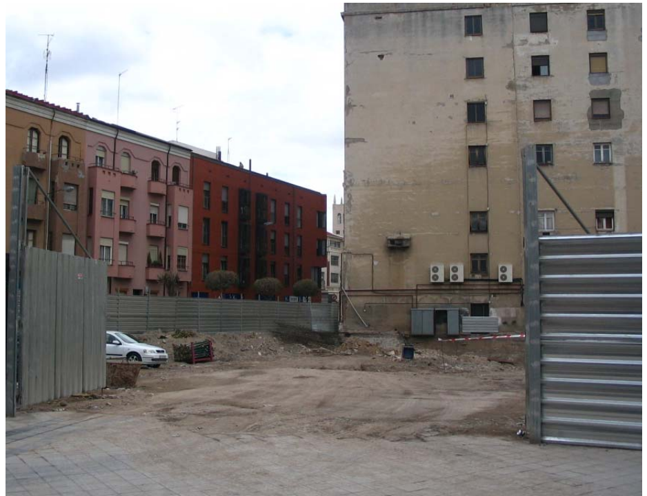
Situación actual de las obras en el terreno ubicado en la calle José María Lacort
